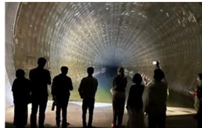
インフラ（地下調節地）
