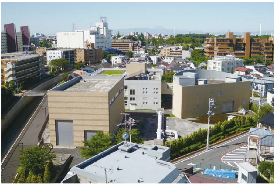
善福寺川取水施設・全景
