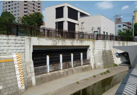
妙正寺川取水施設・取水口
