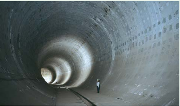
第一期トンネル
