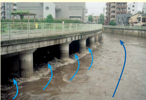
神田川取水施設への流入状況
